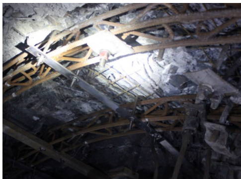
图 8 格栅拱架支护安装图
