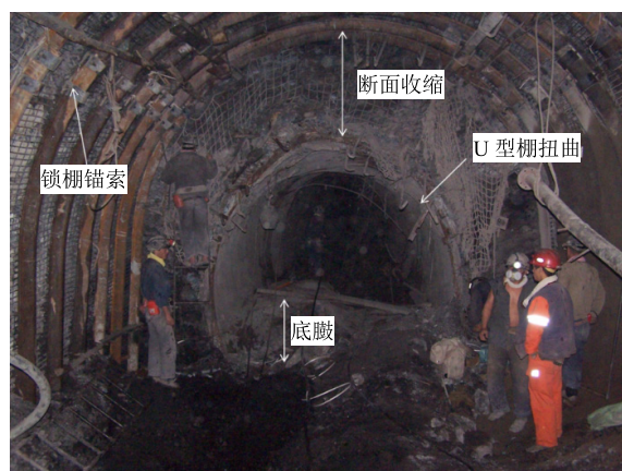
图 1 现有巷道破坏图
